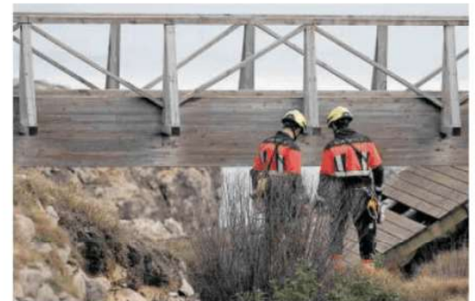
Zona de la pasarela caída en Santander, el día 4. PEDRO PUENTE (EFE)
